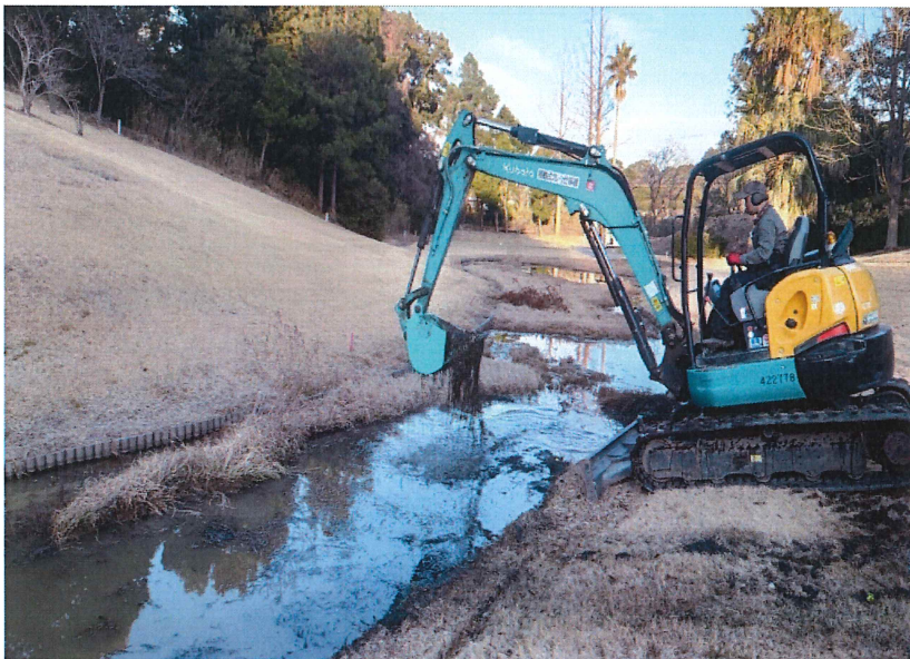
バックホーにて水草・ヘドロ回収
