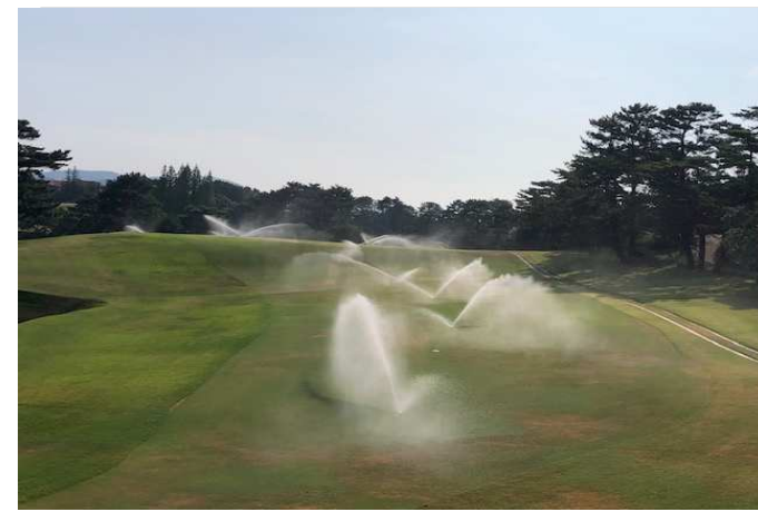
FW散水(埋設スプリンクラーでの散水)No12
