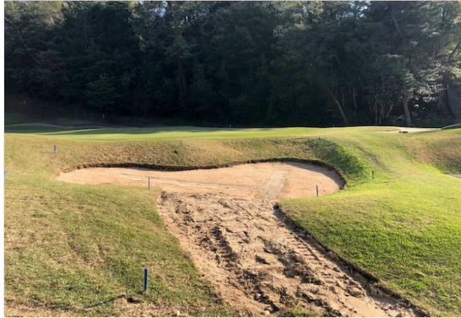
バンカー造成工事(No18グリーン右)2
