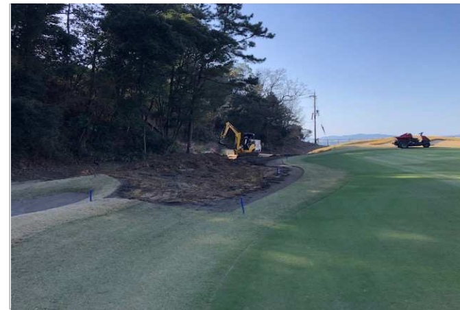
排水工事(No3グリーン左)3
