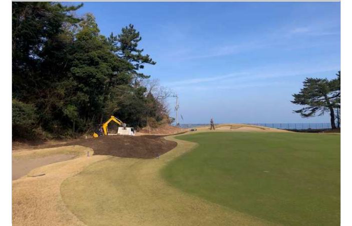
排水工事(No3グリーン左)2
