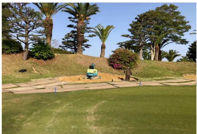
バンカー造成工事(No18グリーン奥)1
