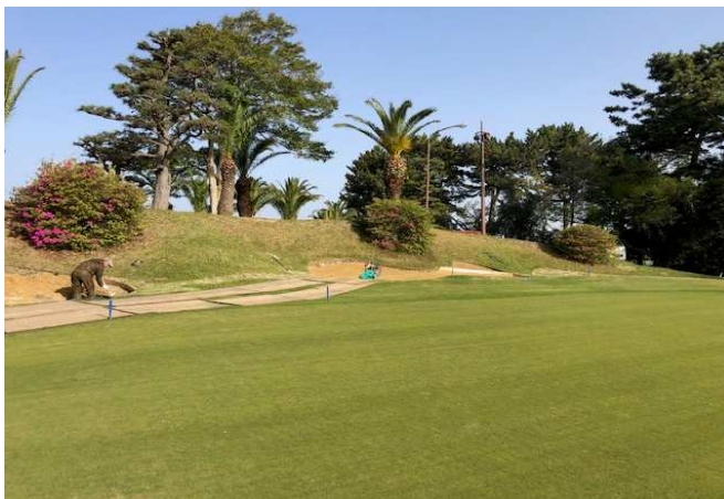
バンカー造成工事(No18グリーン奥)2
