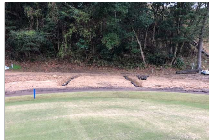
排水工事(No3グリーン左)5
