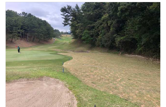
排水工事(No3グリーン左)6
