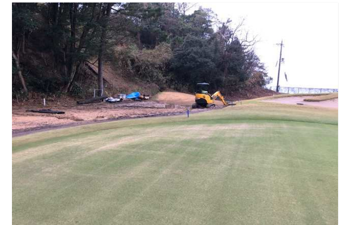
排水工事(No3グリーン左)4
