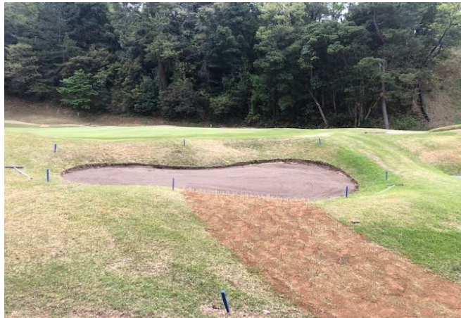
バンカー造成工事(No3グリーン右)4
