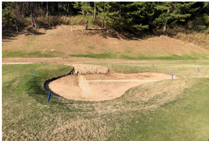
バンカー造成工事(No3グリーン右)3
