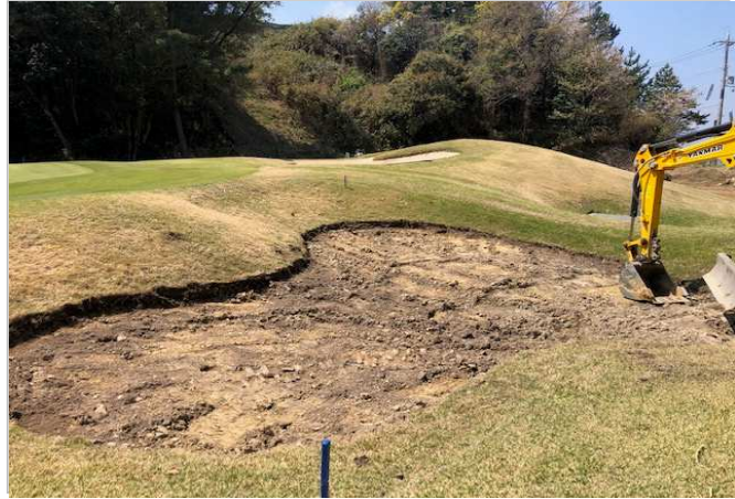
バンカー造成工事(No3グリーン右)1
