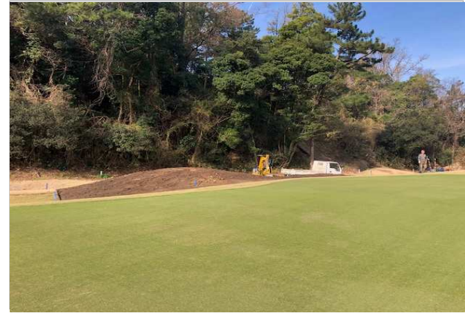
排水工事(No3グリーン左)1
