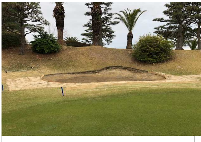
バンカー造成工事 ⑤
