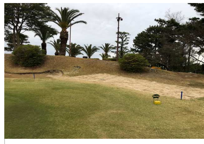
バンカー造成工事 ⑥
