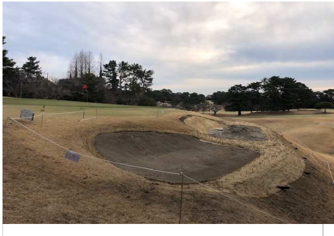
バンカー造成工事 ③
