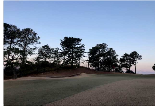
No1グリーン左伐採工事 ①
