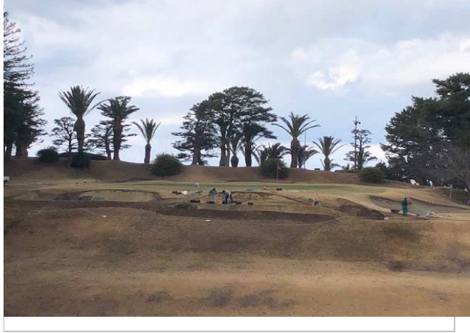
バンカー造成工事 ①
