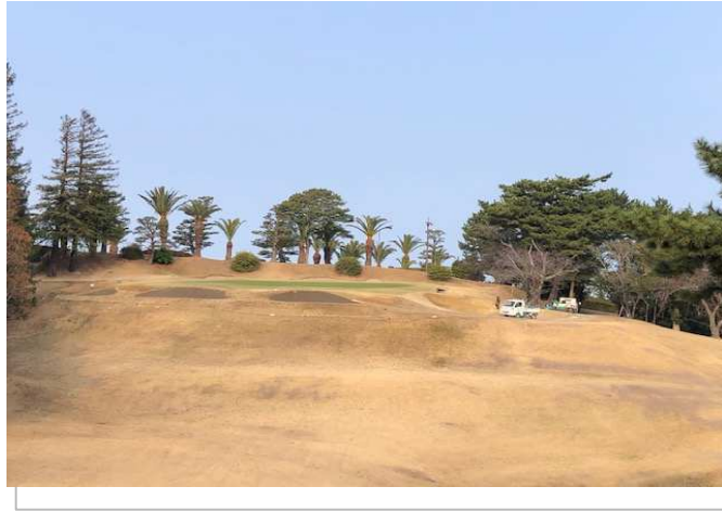
バンカー造成工事 ②
