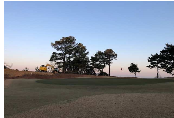
No1グリーン左伐採工事 ③
