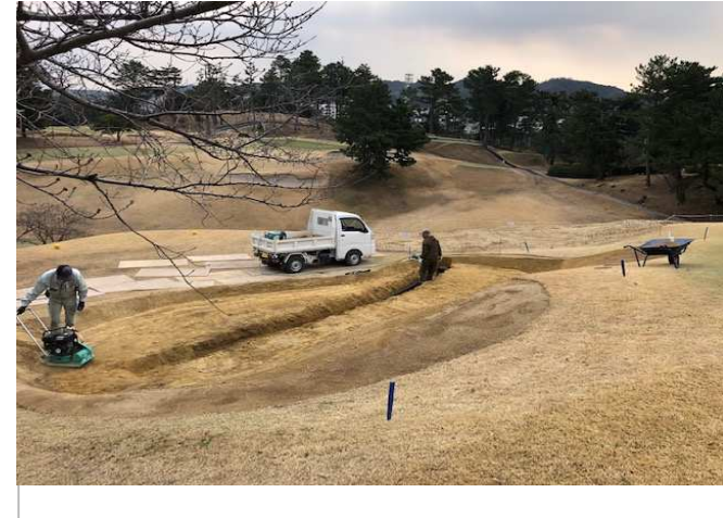
バンカー造成工事 ④
