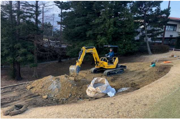
バンカー造成工事 №18①
