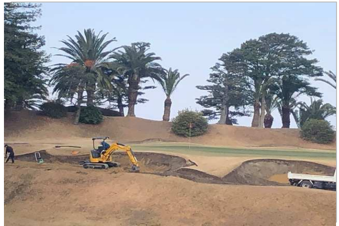
バンカー造成工事 №18②
