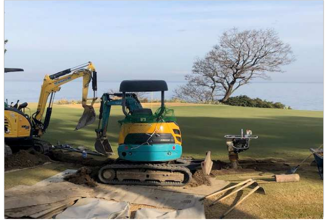
グリーン用スプリンクラー設置工事
