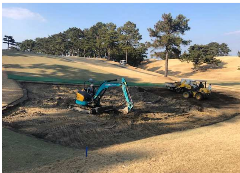
会所、暗渠排水パイプ設置
