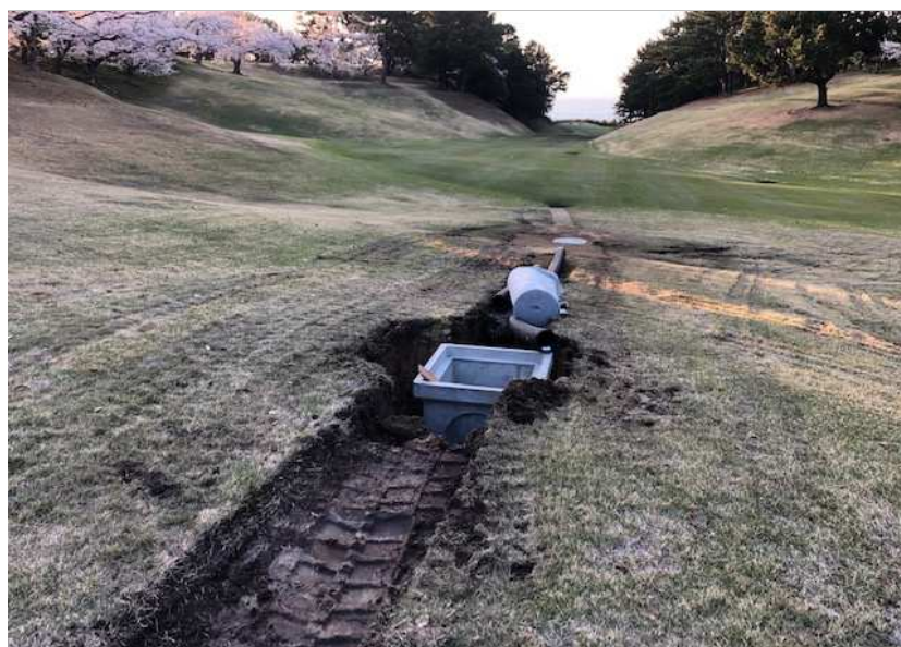
会所、暗渠排水パイプ設置
