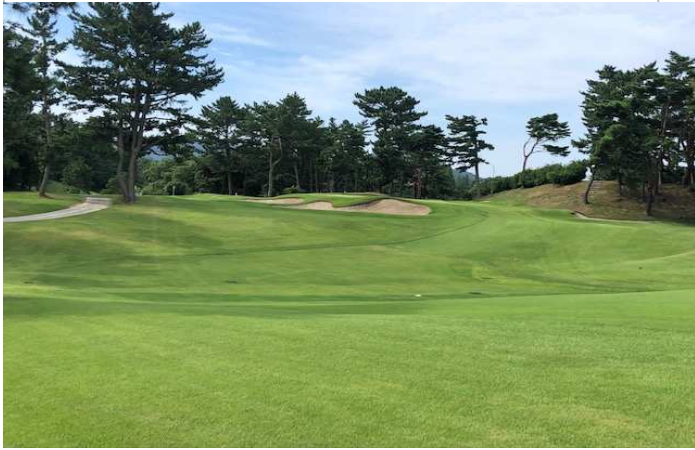
No.8フェアウェイ工事箇所使用開始(7/10)
